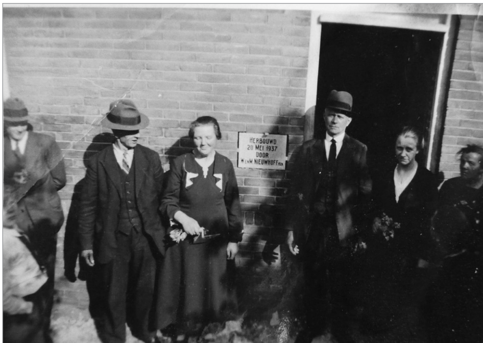
De familie Nieuwhoff bij de eerste steen van de herbouw van het huis aan de Waalseweg 45. Links van de steen Cornelia van der Kleij (een zus van Jan van der Kleij) en Willem Nieuwhoff. Rechts van de steen Minks Nieuwhoff en Jans Nieuwhoff. Het jongetje links is Gerrit Nieuwhoff (zoon van Willem)
